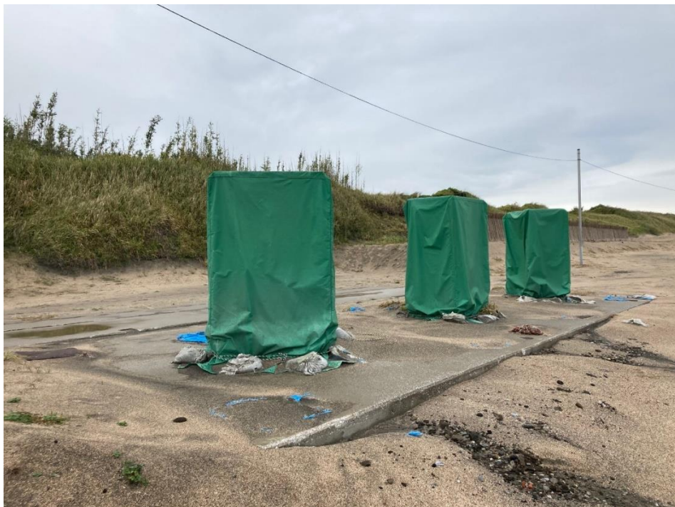
図6 不開設海水浴場でシャワー施設が閉鎖されている様子
