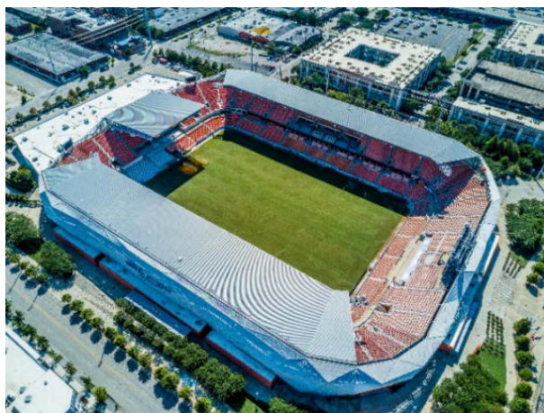
図 39 BBVA Compass Stadium 外観 55
