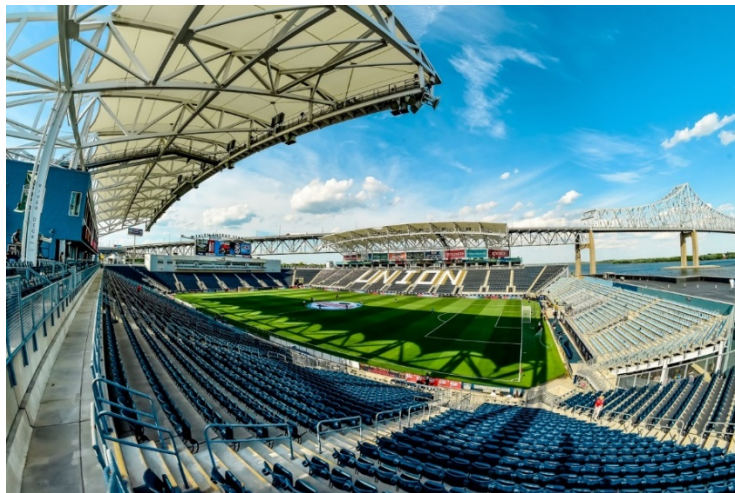
図 35 Talen Energy Stadium 外観 49
